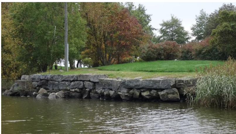
Kuva 2. Räättälinsaaren koillisosan harkkokivipengerryttä. Pengerryttä on perustettu hirsiarokuille. Kuvaussuunta lounaaseen.
