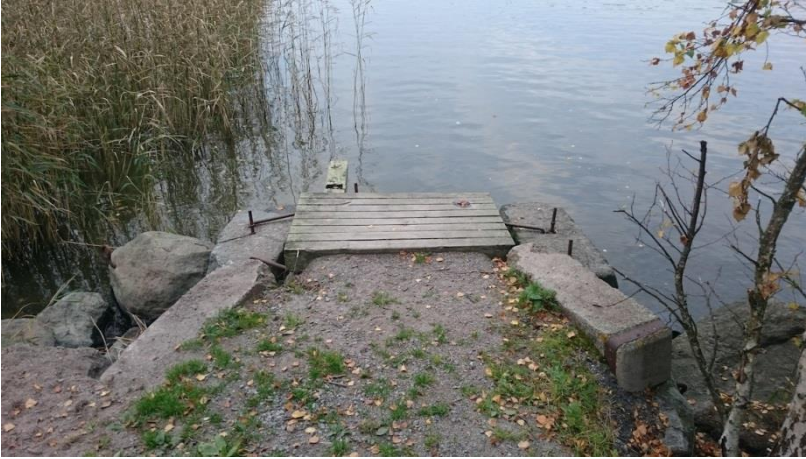
Kuva 19. Räätelinsaaren pohjoispään laiturinperustus ja rannalta kuvattuna. Kuvaussuunta pohjoiseen.
