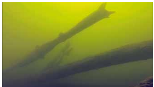
Fig 26. På bilden syns några eroderade timmer i den utfallna stenkistan Id 13. Foto: Jens Lindström/NMG.
