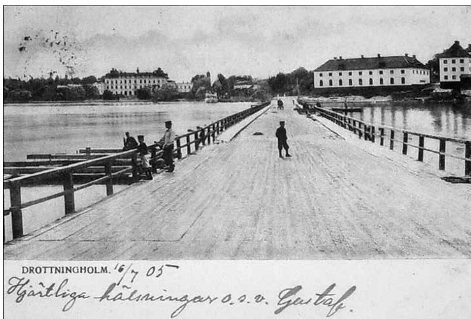
Fig. 6. På ett vykort från 1905 återges flottbron mellan Kårsön och Drottningholm. Träbron ersattes 1925 av en betongbro. Källa: https://slaktakademien.com/2015/07/
