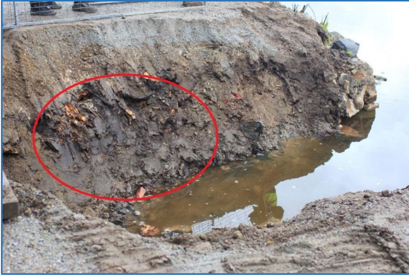
Kuva 5. Valmis kaivanto kuvattuna kohti koillista. Penkkaan on merkitty punaisella puun kannon sijainti ja löytörikkain kerros.
